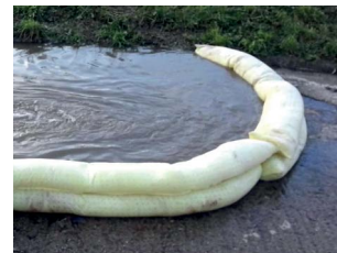
Abbildung 57: Einfach aber wirkungsvoll. Sperre mittels Wasserschutzschlauch.
