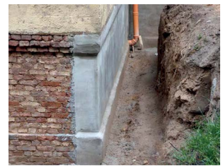
Abbildung 63: Nachträgliche Abdichtung mit wasserdichtem Sperrputz.
