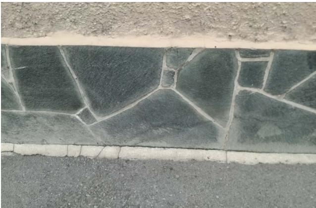
Abbildung 39: Abdichtung mit Verblendmauerwerk.
