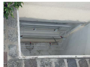
Abbildung 58: Wasserdicht verschließbares Kellerfenster.
