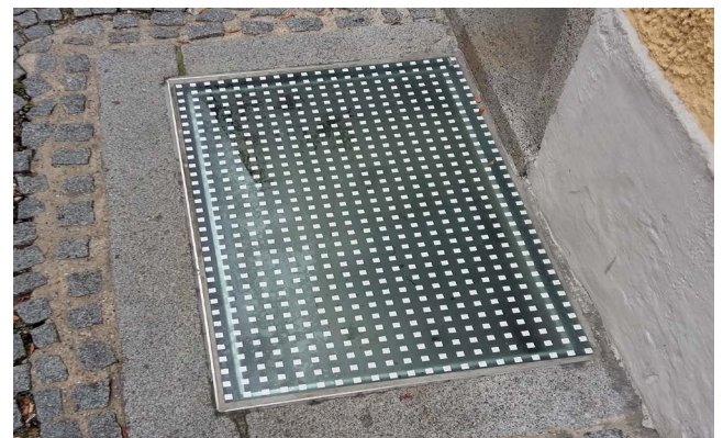
Abbildung 36: Abgedichteter Lichtschacht.
