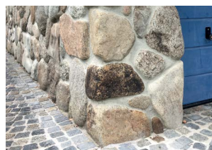
Abbildung 52: Während des Starkregens (oben) und nach Rückgang des Wassers (unten). Durch die fachgerechte Verwendung wasserbeständiger Baustoffe entstanden keine Schäden. Lediglich eine Hochdruckreinigung der Außenwände war notwendig.
