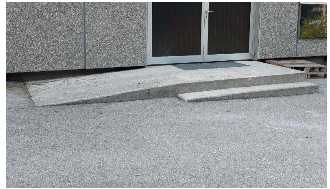
Abbildung 27: Höher gelegter Eingang schützt vor Wassereintritt.
