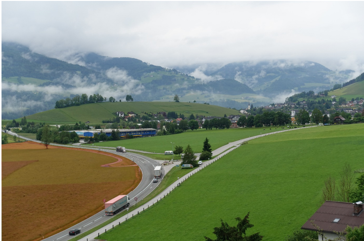
Abbildung 3: Fotostandpunkt Nr.1. Blick Richtung WSW. Westlicher Bereich der VZ und Sichtachse in das Ortsgebiet (Quelle: PLANUM, Ch. Harg, 09.06.2016)
