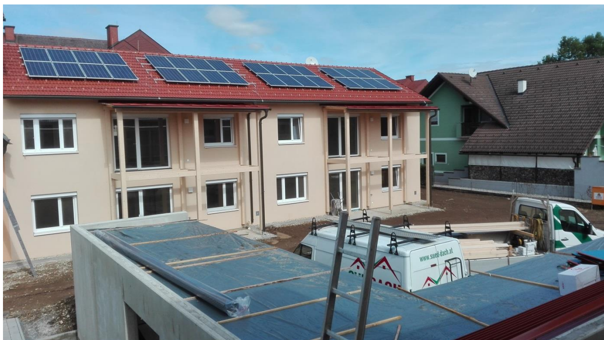
Abb. 9 Haus 4 bei Fertigstellung - Südseite
