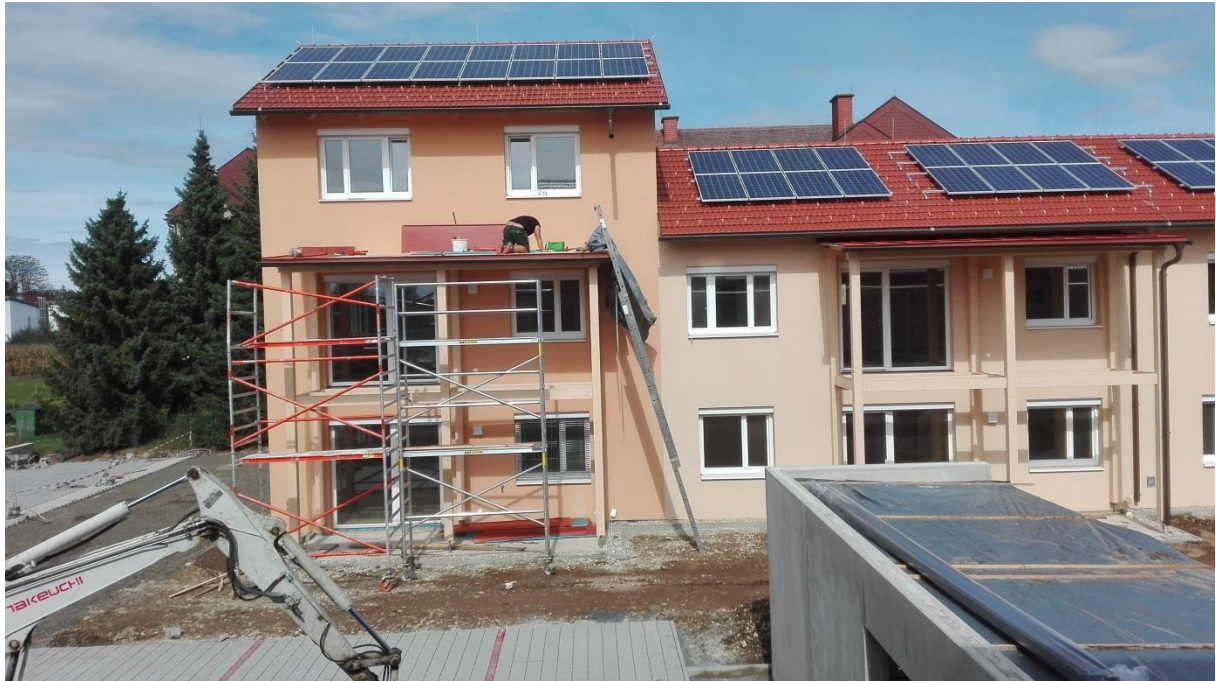
Abb. 10 Haus 4 bei Fertigstellung - Südseite
