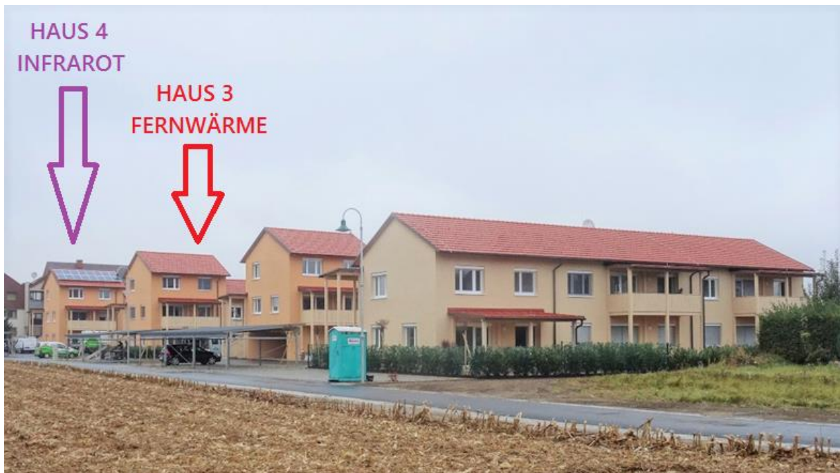
Abb. 8 Foto Siedlung (Haus 4 ganz hinten mit PV-Anlage, Haus 3 davor)
