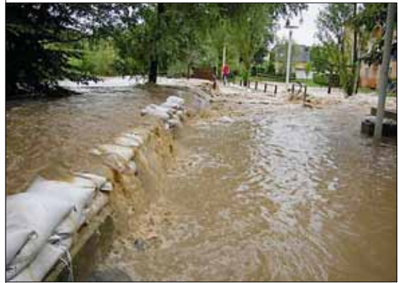
Abb. 2: Hochwasserereignis Schöckelbach im August 2009
