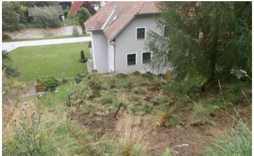
Abb. 1: Massive Rutschungen hinter dem Mehrparteienhaus in der Desider-Kastner-Allee © A14
