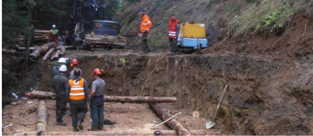
Abb. 7: Aufbauarbeiten einer Holzkrainerwand im Palsgraben © A14
