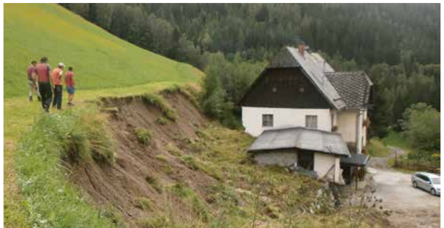
Abb. 4: Rutschmassen hinter dem Gehöft Geyer © A14
