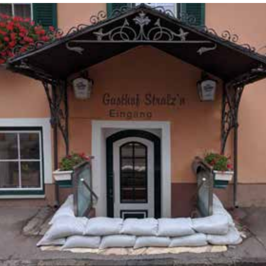
Abb. 2: Mobiler Schutz des Hauseingangs mittels Sandsäcken © A14/Hornich
