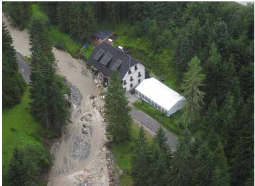
Abb. 5: Stark beschädigtes ÖAV-Berghaus im Walchental © WLV
