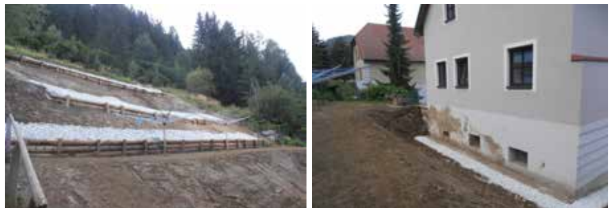
Abb. 2 und 3: Mehrparteienhaus Desider-Kastner-Allee nach der Sicherung © A14
