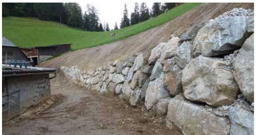
Abb. 5: Gehöft Geyer nach der Sicherung mittels Steinstützkörper © A14
