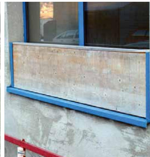
Abb. 4: Schutz eines Fensters mittels Dammbalken © EPZ/Vanic
