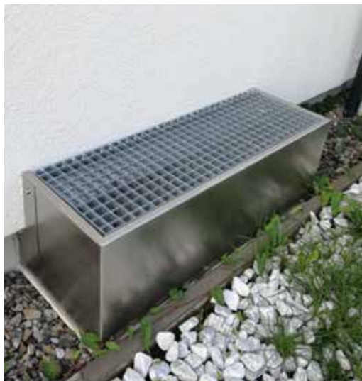
Abb. 3: Erhöhung der Lichtschachtoberkante © Lederer
