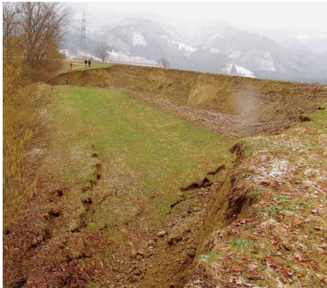
Abb. 2: Anbruch der Rutschung
