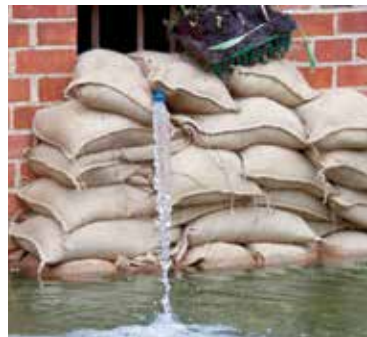
Abb. 4: Sandsäcke mit Entwässerung des dahinterliegenden Raumes (Quelle: THW Deutschland).
