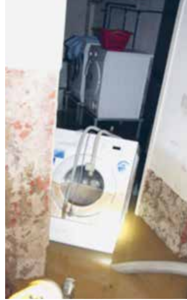
Abb. 3: Überfluteter Keller mit Waschmaschine, die am Boden stand und den beiden Trocknern im Hintergrund, die auf einer höheren Plattform aufgestellt wurden (Quelle: MA 10/5).
