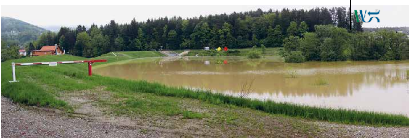
Abb. 3: Eingestautes Hochwasserrückhaltebecken am Schöcklbach in der Gemeinde Weinitzen (Foto: B. Egger-Schinnerl)
