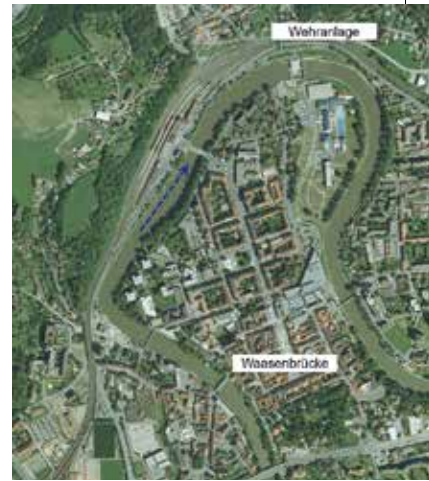
Abb. 5: Kraftwerk Leoben an der Mur im Stadtgebiet Leoben [10]
