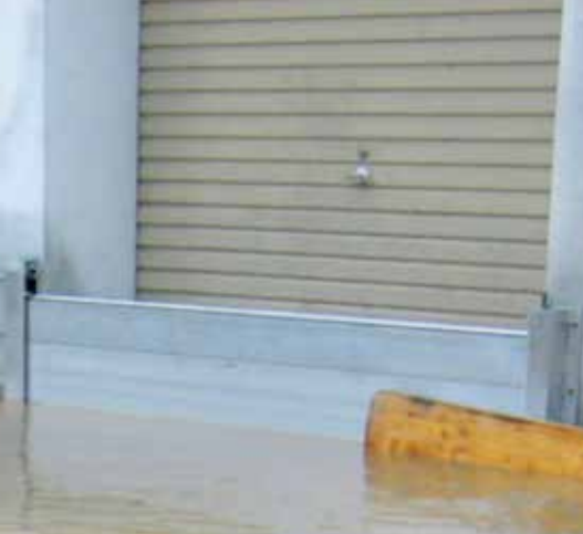
Abb. 5: Balkensystem im Einsatz bei einer Garage (Quelle: MA10/5).
