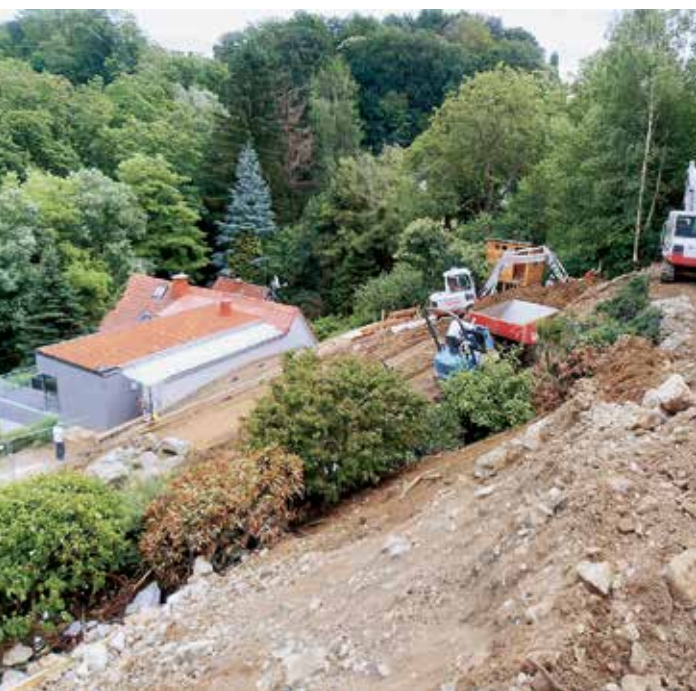
Abb. 5: Bauarbeiten Hangstabilisierung Rutschung Reinerkogel
