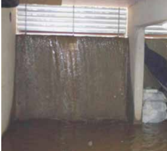
Abb. 6: In einer Tiefgarage besteht die Gefahr, dass durch die Licht- bzw. Lüftungselemente eindringendes Wasser große Schäden verursachen kann (Quelle: MA 10/5).
