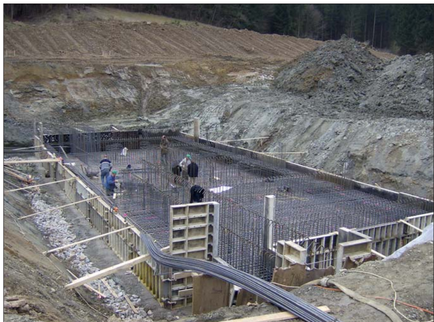
Abb. 1: Errichtung der Fundamentplatte
