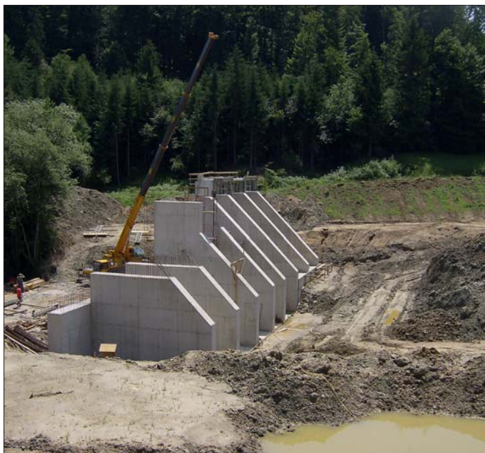
Abb. 3: Errichtung der Stahlbetonmauern mit den Abstützungsrippen
