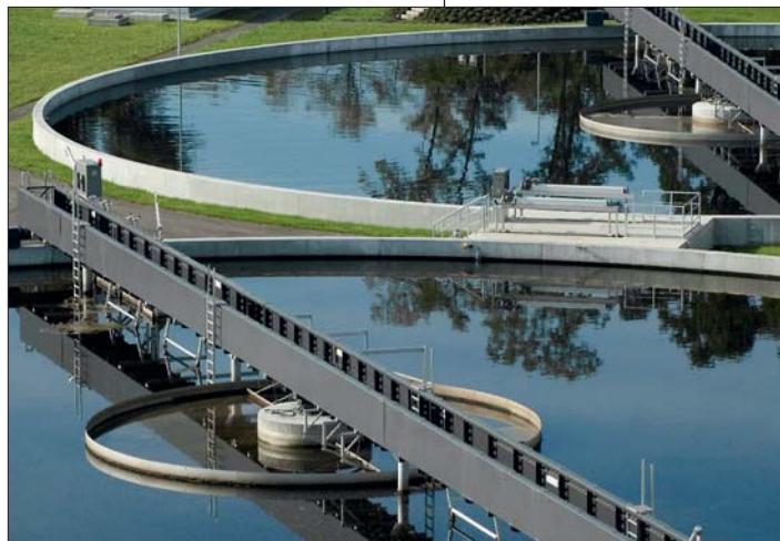
Die Kläranlage in Gössendorf zählt zu den modernsten in Europa
