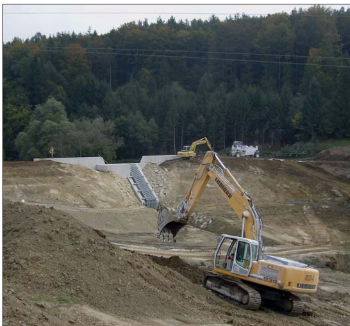
Abb. 4: Finalisierungsarbeiten am Hochwasserschutzdamm des RHB Labuchbach
