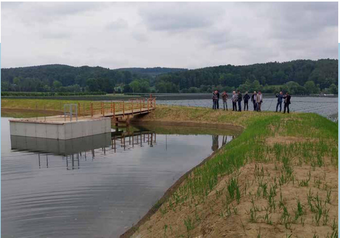
Abb. 3: Speicherteich für Trocken- und Frostberegnung bei kleinen Vorflutern in der Oststeiermark © A14
