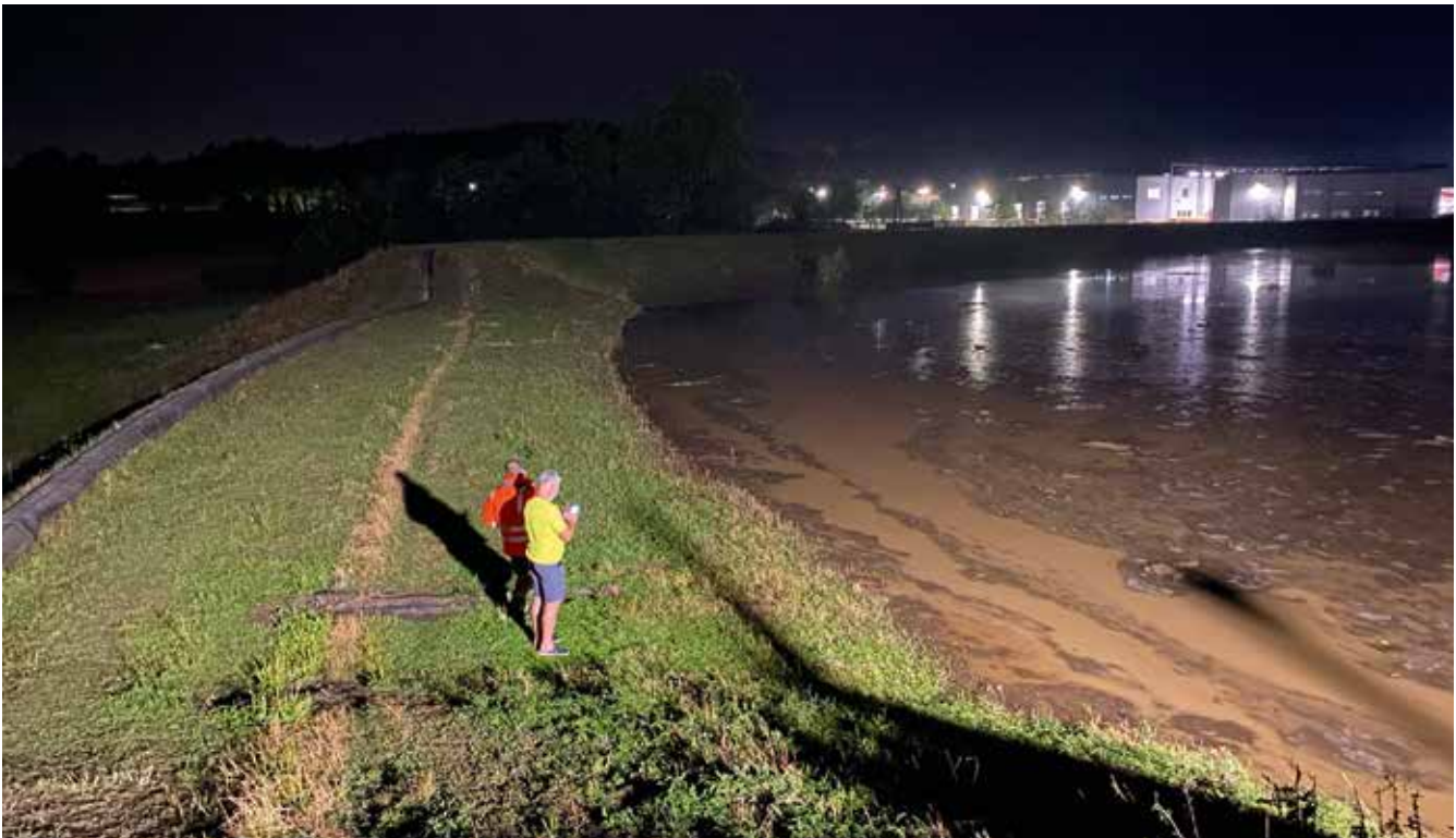
Abb. 9: Volleinstau am Rückhaltebecken Raababach © igbk
