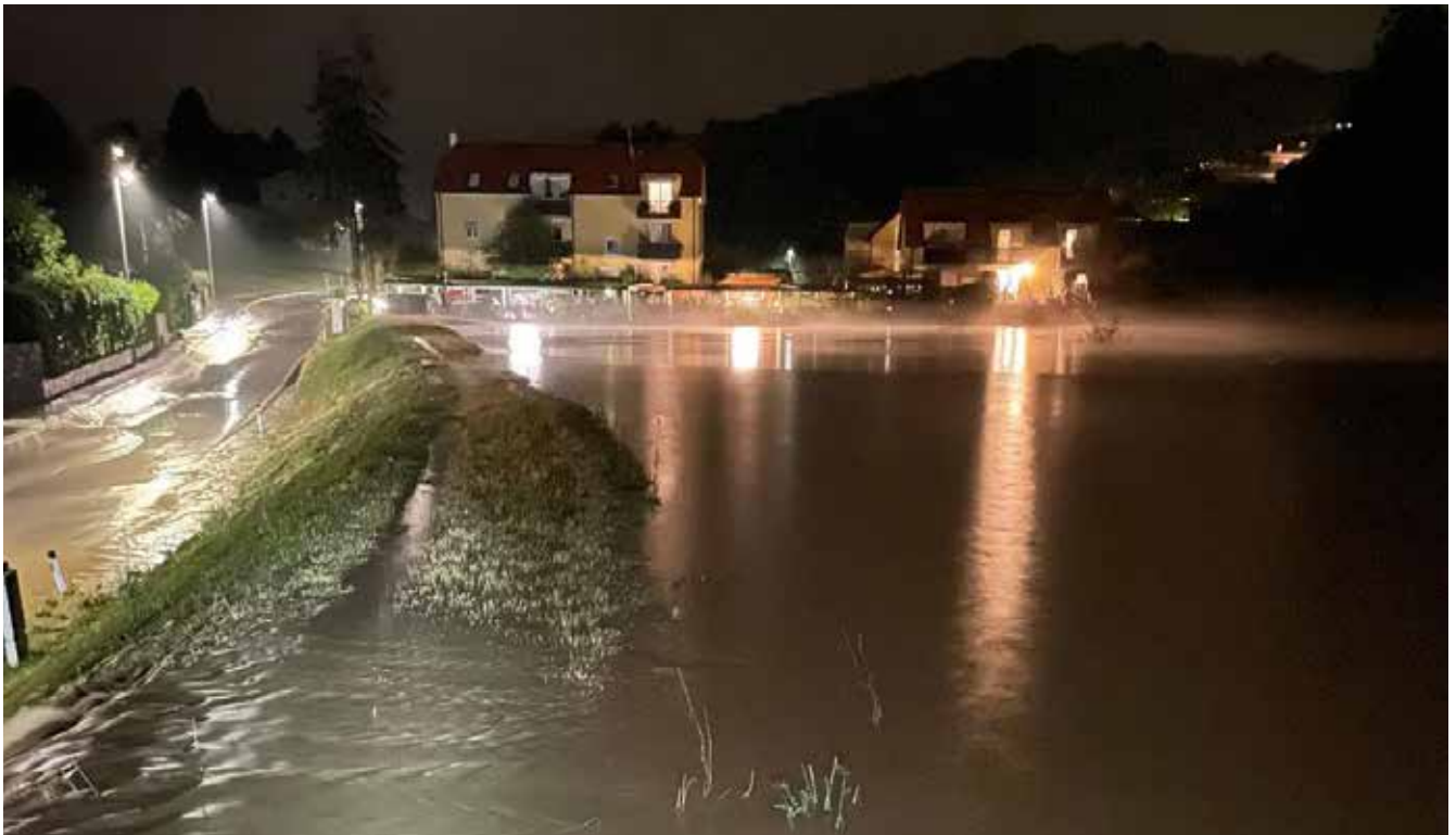
Abb. 6: Anspringen der Hochwasserentlastung am Rückhaltebecken Stufenbach, Ziegelstraße © KK
