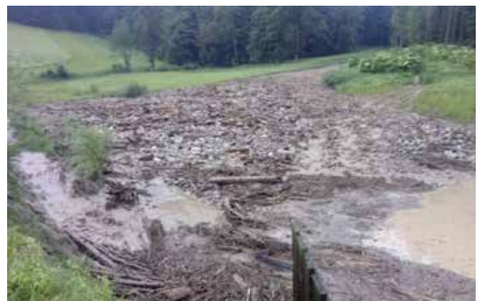
Abb. 2: Rückhalteraum mit ausgefiltertem Geschiebe und Wildholz © WLV
