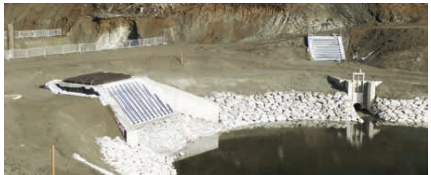
Abb. 2: Bauphase 2015, Einlaufbauwerk Grundablass, Bypass einlauf © WLV
