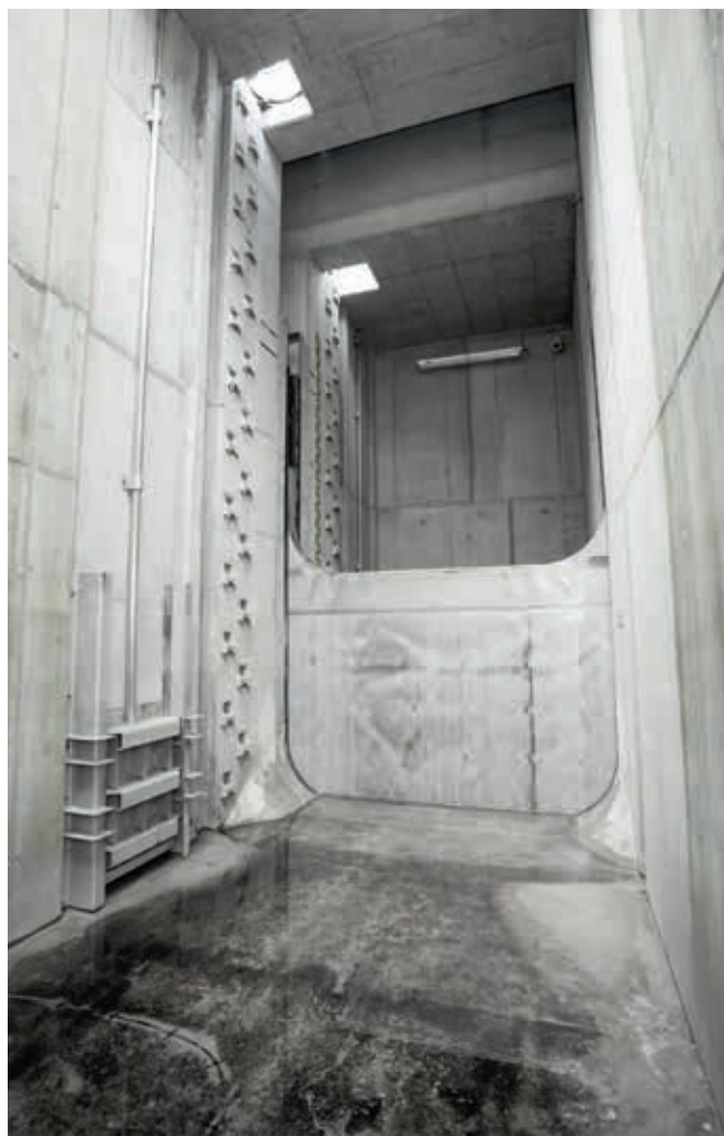
Abb. 3: Kaskadenbauwerk im Endzustand © Foto Fischer
