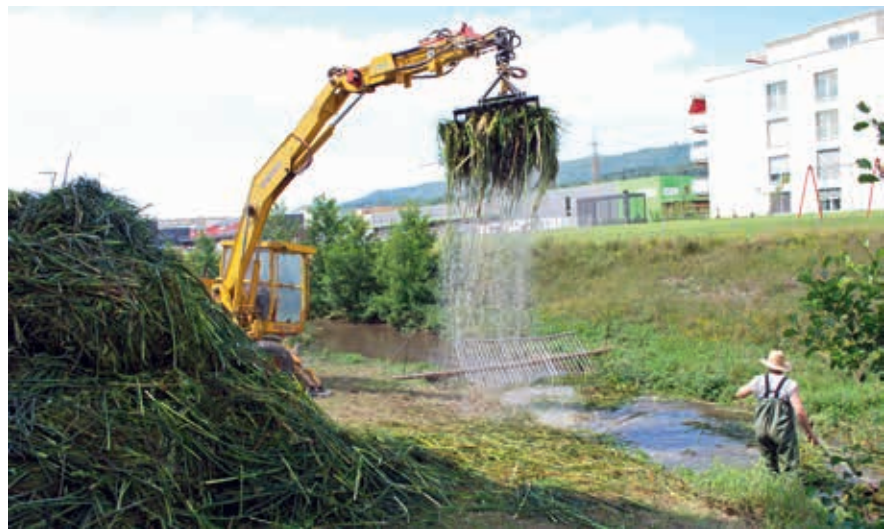
Abb. 3: Regelmäßiges Mähen von Bach- und Flussböschungen sind wichtige Arbeiten. © AWEL, Kt. Zürich
