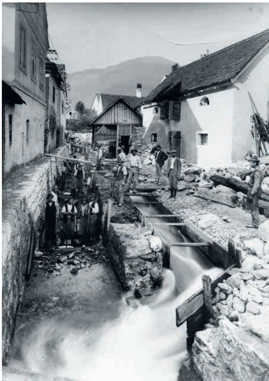
Abb. 1: Unterlaufregulierung © WLV, Gebietsbauleitung Steiermark Nord
