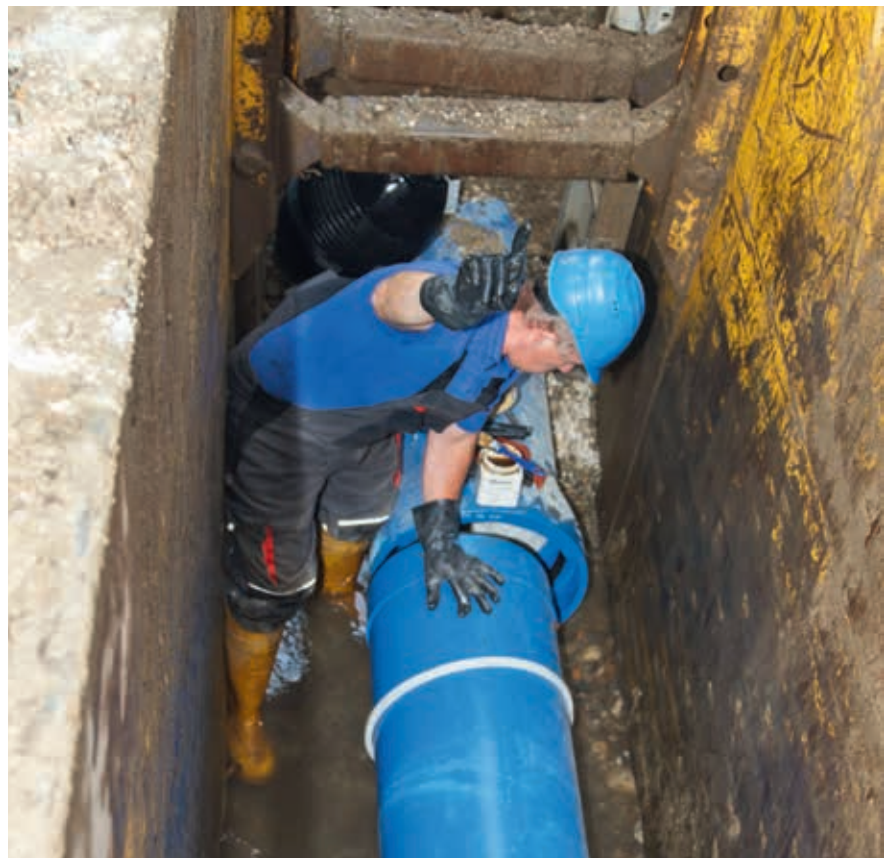
Abb. 1: Die Verlegung von Wasserleitungen schafft Infrastruktur und Arbeitsplätze. © Leibnitzerfeld Wasserversorgung GmbH
