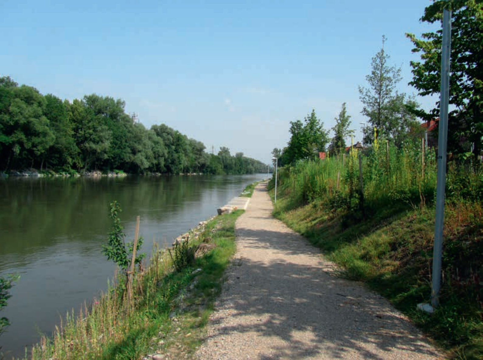
Abb. 5: Böschungswiederherstellung - 1. ZSK-Abschnitt, 1 Jahr nach Bau © Stadt Graz, A10/5
