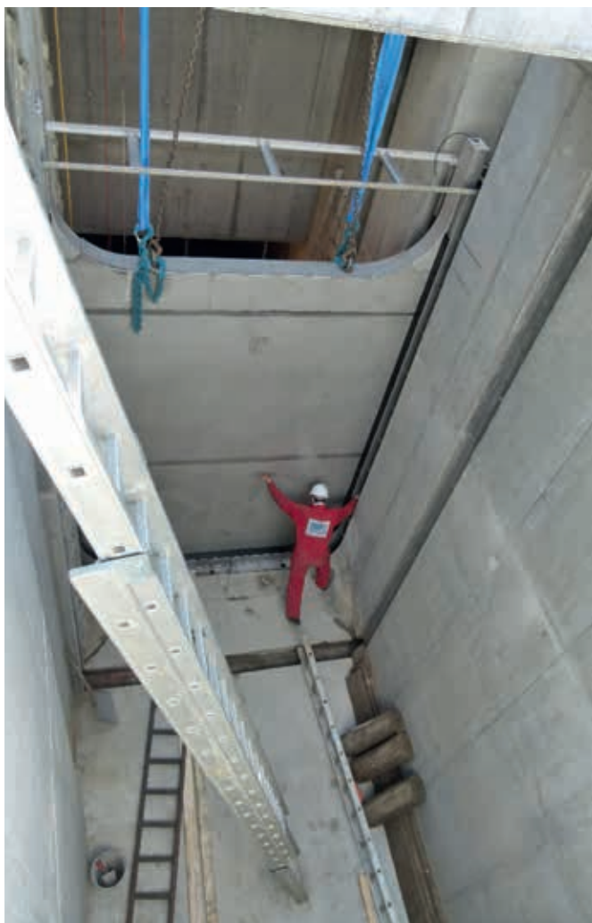
Abb. 2: Kaskadenbauwerk, Montage © Holding Graz
