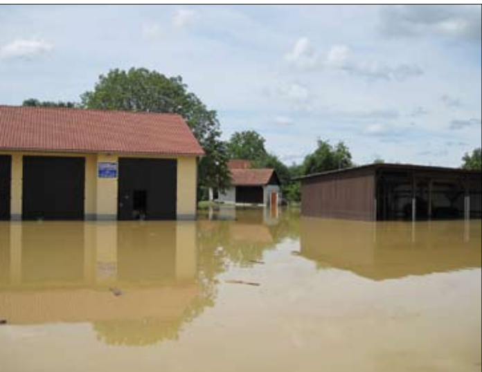
Hochwasser am 25. 06. 2009 in der Gemeinde Gosdorf (Saßbach)
