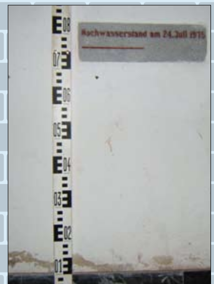
Abb. 18: Hochwassermarkierung Stift Rein (Kreuzgang), vom 24. Juli 1975, Wasserstand ca. 77 cm, noch heute sichtbare Hochwasserschäden an abblätternden Farb- und Verputzschichten im unteren Bildbereich;
