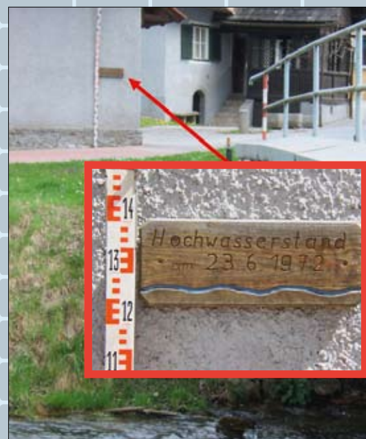
Abb. 17: Hochwassermarkierung Afling, vom 23. Juni 1972, Wasserstand ca. 125 cm, im Vordergrund die Kainach (Originalstandort der Hochwassermarkierung ist fraglich);
