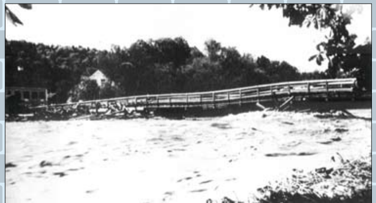
Abb. 10: Murbrücke in Frohnleiten beim Hochwasser 1938 mit angestautem Schwemholz; Quelle: SUPPAN, 1984
