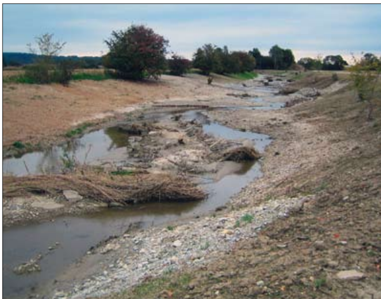
Abb. 2: Hühnerbach – Zustand unmittelbar nach Baufertigstellung
