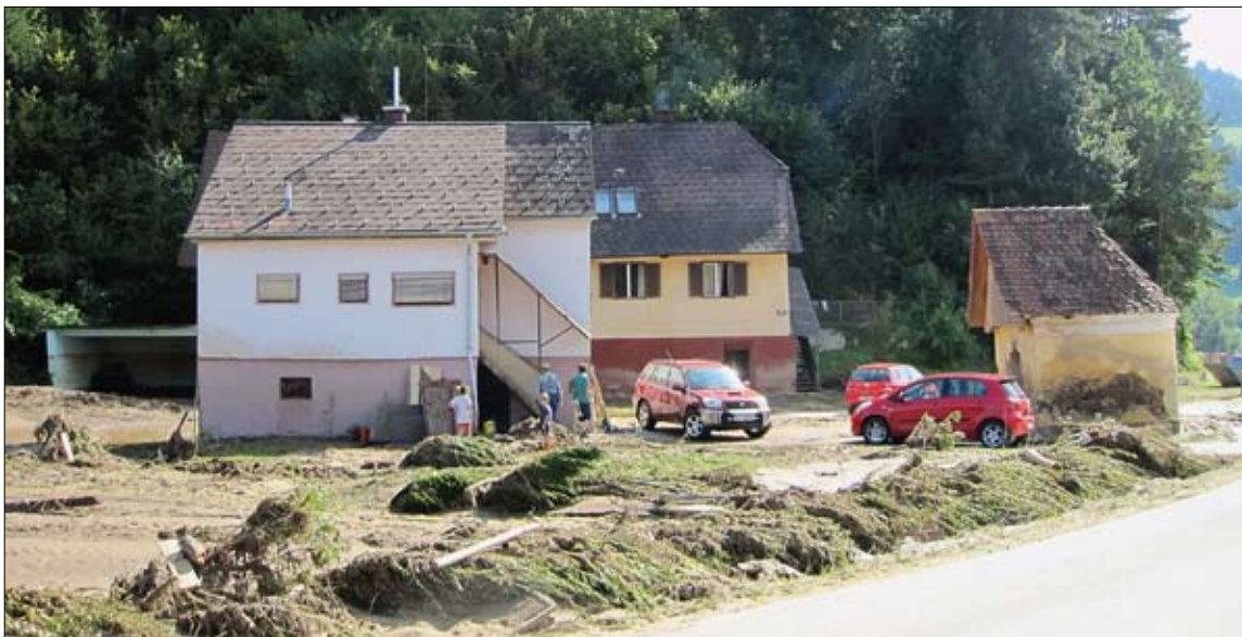
Schäden nach dem Hoch- wasser am 22. 08. 2009 am Gößnitzbach
