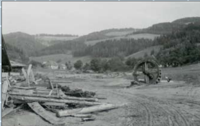
Abb. 13: Hochwasser vom 25. Juli 1948 in Kleinlobming, Gugelbauer, Wasserrad von der Mühle wurde ca. einen Kilometer von den Wassermassen mitgeführt; Quelle: Prutti J.
