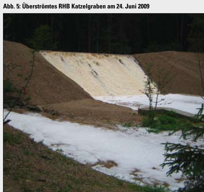
Abb. 5: Überströmtes RHB Katzelgraben am 24. Juni 2009
