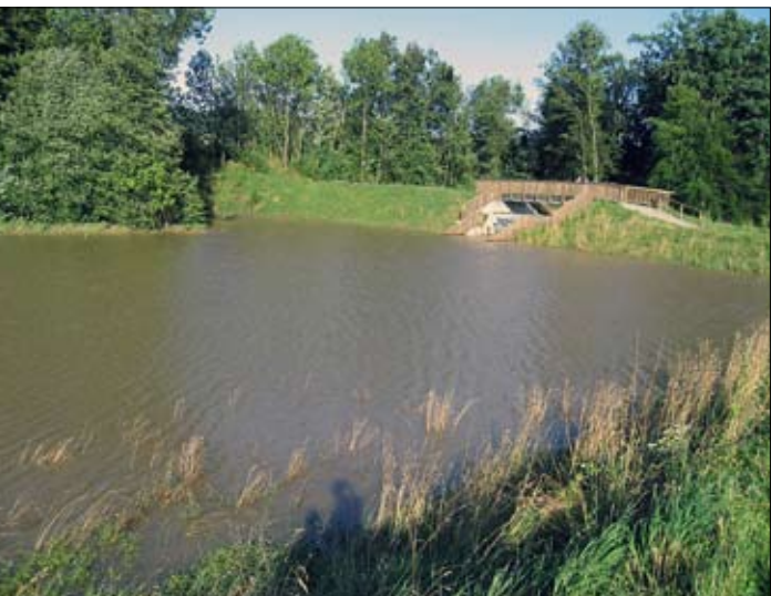
Eingestautes Rückhaltebecken am Gabriachbach/Graz Andritz am 18. 07. 09
