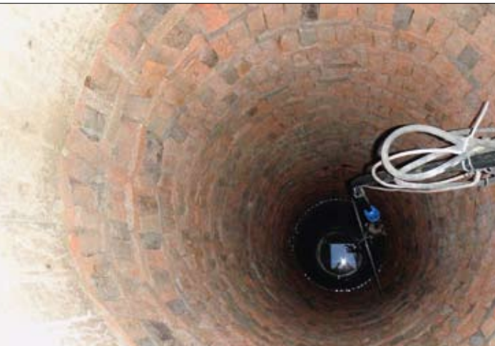
Abb. 5: Mit Ziegeln ausgekleideter Brunnenschacht
