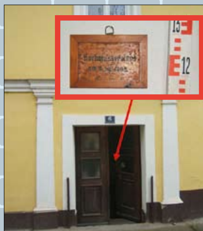
Abb. 15: Hochwassermarken Mautern, vom 8. Juli 1953, Wasserstand ca. 127 cm, (Originalstandort der Hochwassermarken ist fraglich); Foto: Prettenhofer
