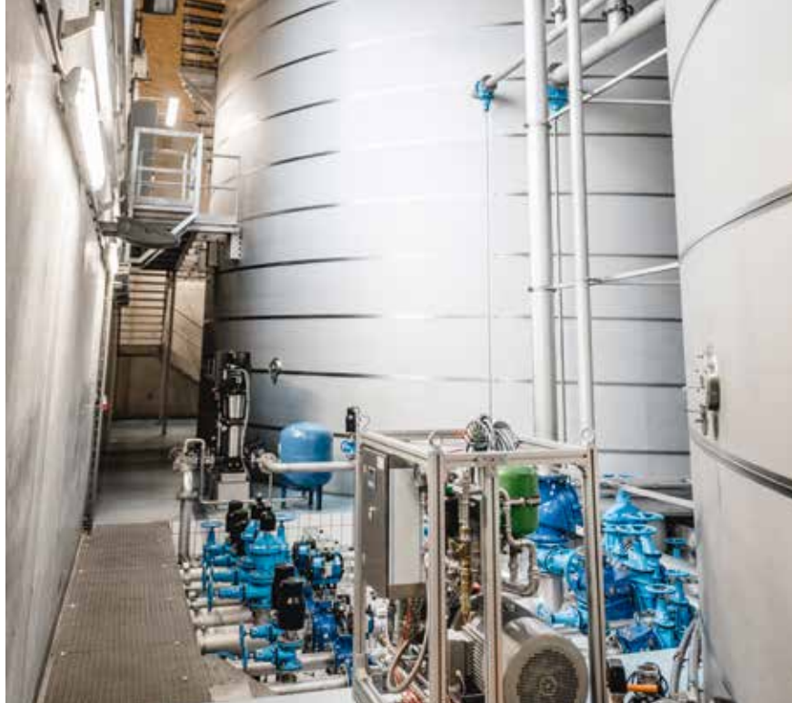
Abb. 1: Edelstahl tanks mit Schieberkammer © Wasserverband Leibnitzerfeld-Süd
