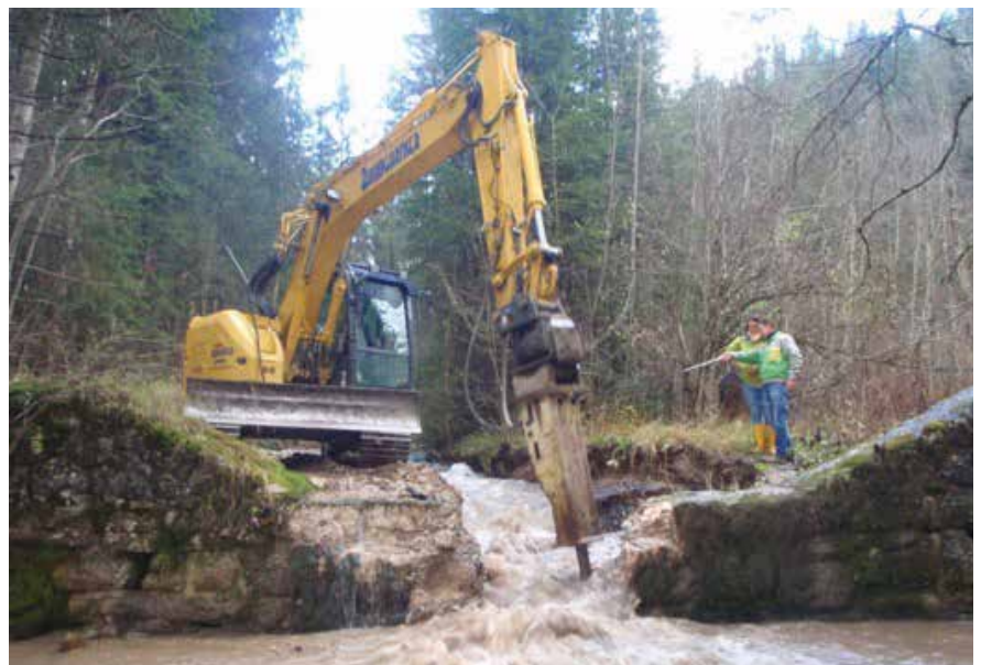
Abb. 5: Der Bagger der Wildbach- und Lawinerverbauung schrämt eine Sperre und öffnet so den Fluss zur Durchwanderung von Steinkrebs und Koppe © ÖBf-Archiv/H. Haseke
