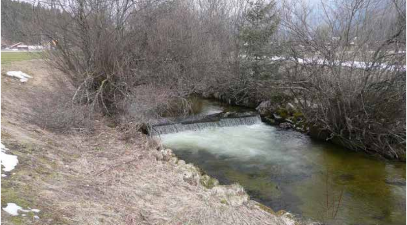
Abb. 6: Eine Sohlschwelle vor dem Umbau stellt ein großes Hindernis für Koppen dar © U. Suppan
