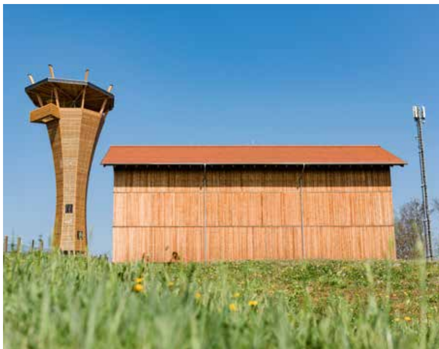
Abb. 2: Aussichtsturm neben den Wasserbehältern © Wasserverband Leibnitzerfeld-Süd
