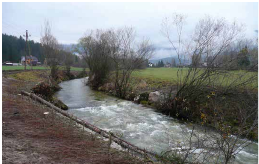
Abb. 7: Aufgelöste Sohlstufe © U. Suppan
