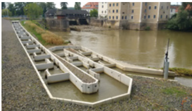
Abb. 40: Adaptierter technischer Schlitzpass - KW Berghofer-Mühle © Abteilung 14
