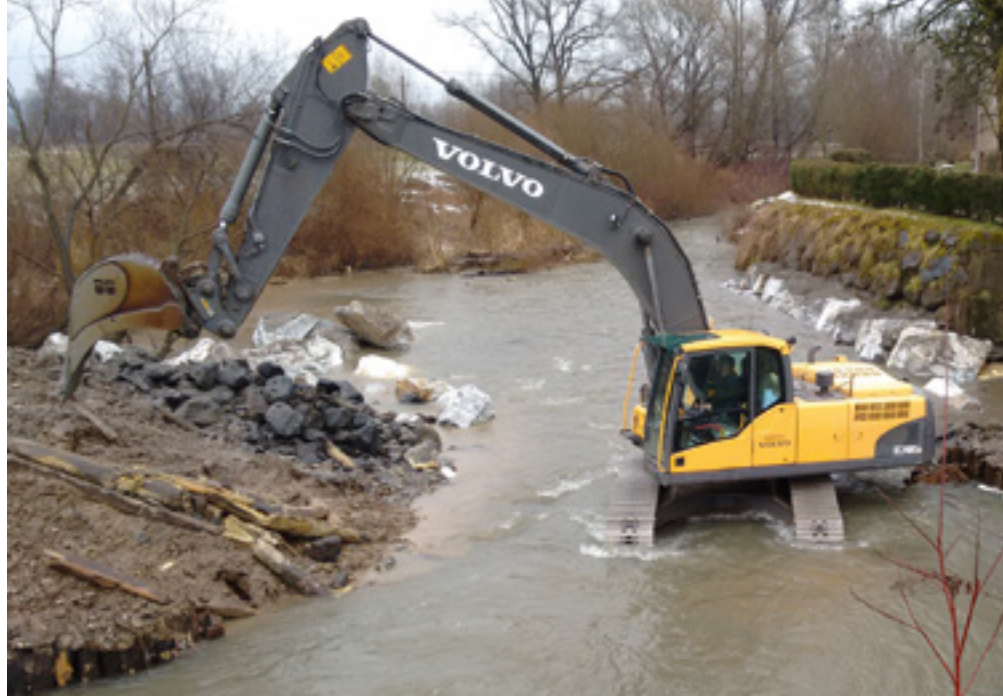
Abb. 30: Abriss des Streichwehres © Abteilung 14
