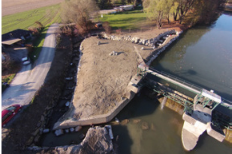
Abb. 35: Naturnaher Beckenpass – KW Felber © BWI GmbH, Spurej
