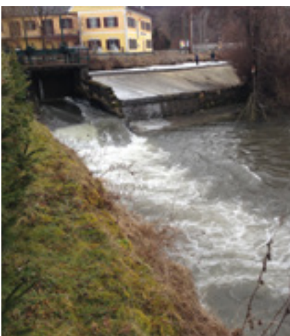
Abb. 28: Streichwehr Pölmühle vor dem Umbau © G. Parthl / IB Parthl
