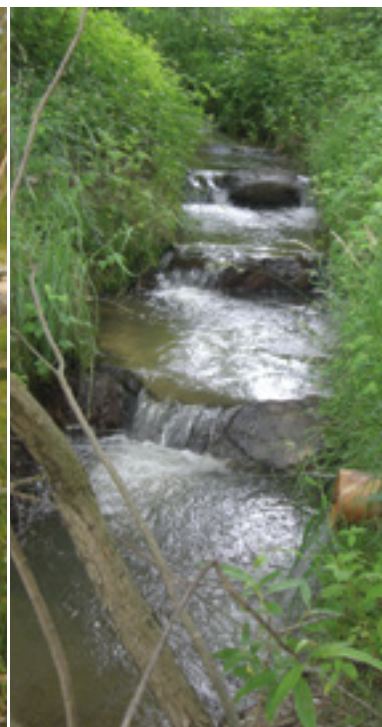
Abb. 10: Alter Bautyp eines Beckenpasses mit abgelöstem Überfall © Abteilung 14
