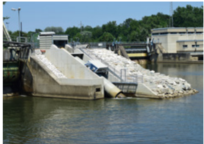
Abb. 17: KW Retznei an der Sulm mit Fischschnecke im Vordergrund, im Hintergrund das KW Obervogau an der Mur © Parthl / IB Parthl
