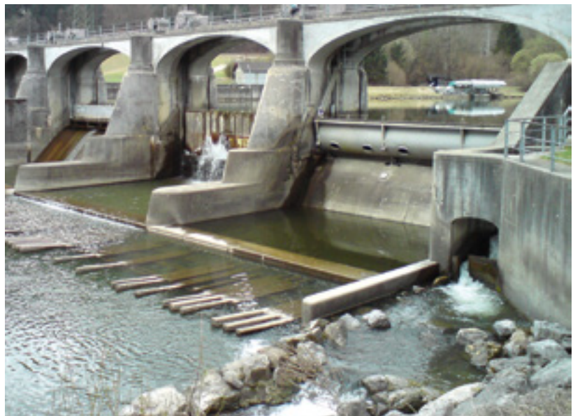
Abb. 6: Technischer Beckenpass, sogenannte „Cail'sche Treppe“ aus dem Jahr 1906 – Wehranlage Adriach – Mur © Land Steiermark
