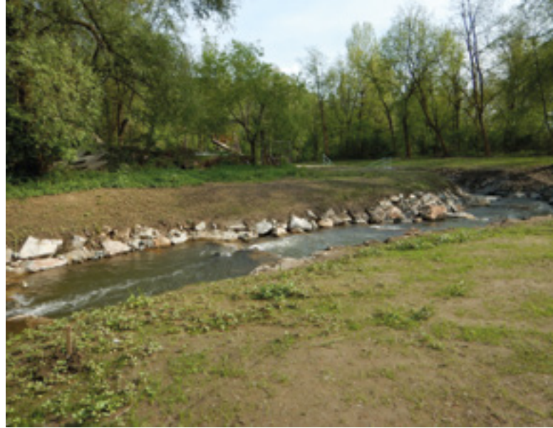
Abb. 21: Beckenpass als Verbindung zwischen Weissenegger Mühlkanal und Begleitgraben des KW Gabersdorf © Abteilung 14
