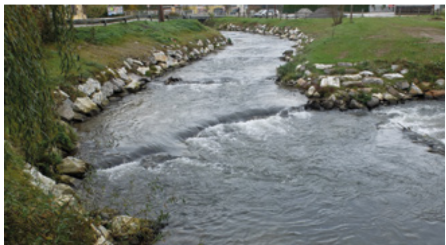
Abb. 29: Streichwehr Pölmühle nach dem Umbau © Abteilung 14
