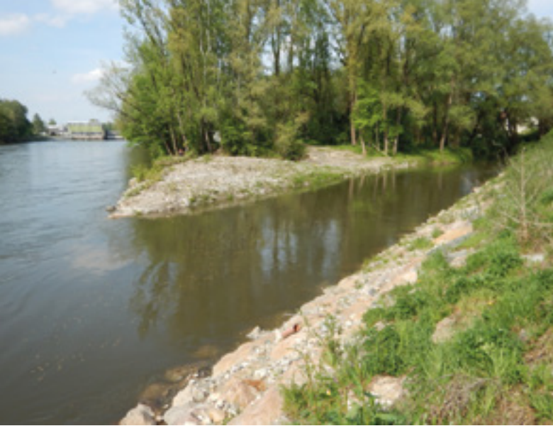
Abb. 20: Umgebaute Mündung des Weissenegger Mühlkanals unterhalb des KW Gabersdorf © Abteilung 14
