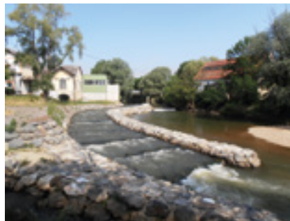
Abb. 44: Teilsohlrampe bei der ehemaligen Ertler-Mühle © Abteilung 14
