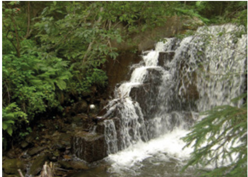
Abb. 5: Historische Fischschleuse; Obersteiermark © Land Steiermark
