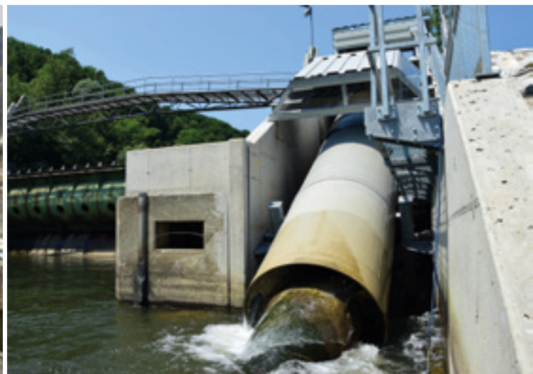
Abb. 13: Fischaufstiegsschnecke - KW Retznei - Sulm © Parthl / IB Parthl
