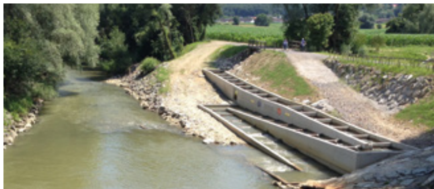
Abb. 37: Schlitzpass - KW Hohenbrugg © Parthl / IB Parthl
