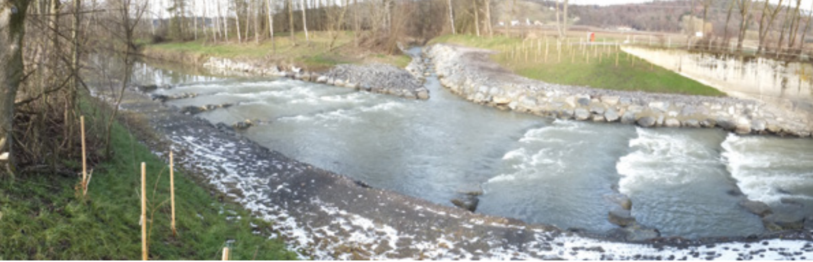
Abb. 46: Sohlrampe bei Schiefer mit der Mündung des Grazbaches © Schmid / IB Parthl
