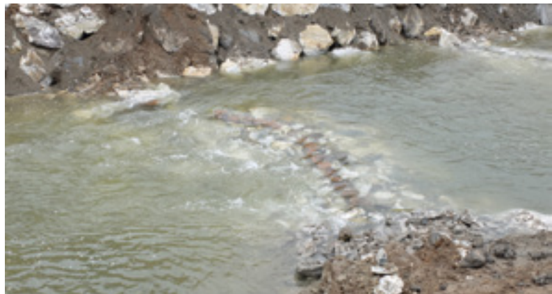
Abb. 32: Querriegel aus Holzpiloten und Steinen, nach Fertigstellung © Abteilung 14
