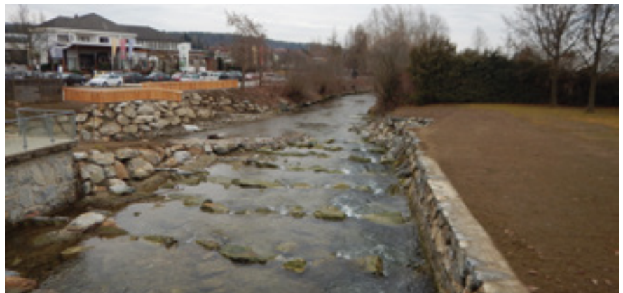
Abb. 47: Aufgelöste Rampe bei der Badeanlage St. Ruprecht © Abteilung 14
