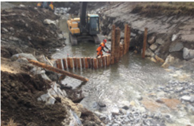
Abb. 31: Querriegel aus Holzpiloten und Steinen, im Bau © G. Parthl / IB Parthl
