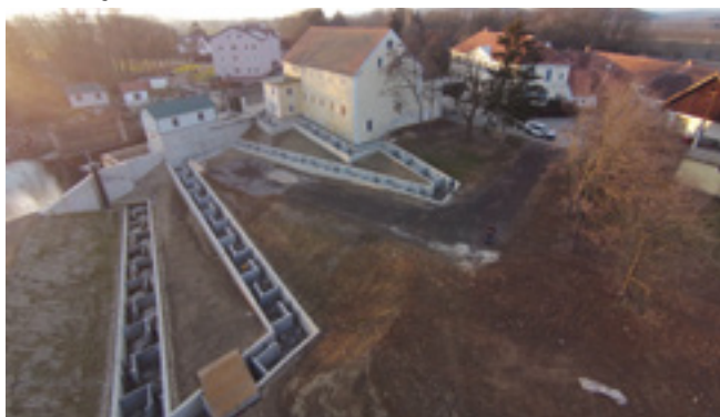
Abb. 39: Schlitzpass bei KW Wagnermühle © BWI GmbH, Spurej
