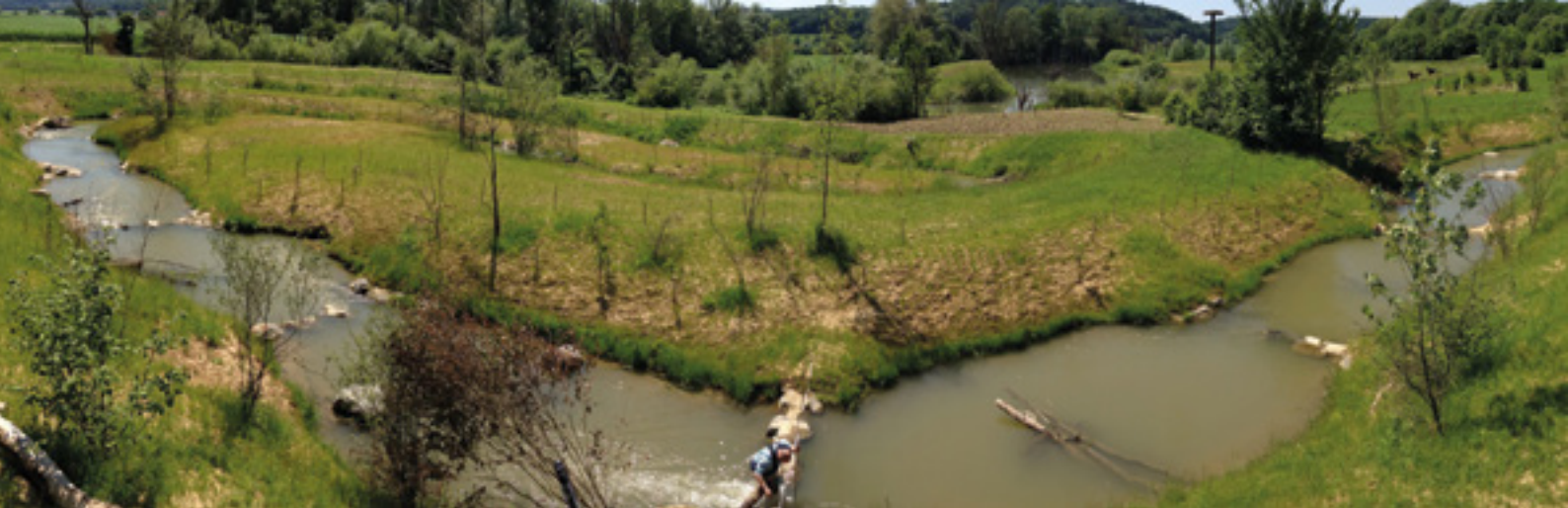
Abb. 38: Umgehungsgerinne beim KW Hohenbrugg rund 3 Monate nach Fertigstellung © Parthl / IB Parthl
