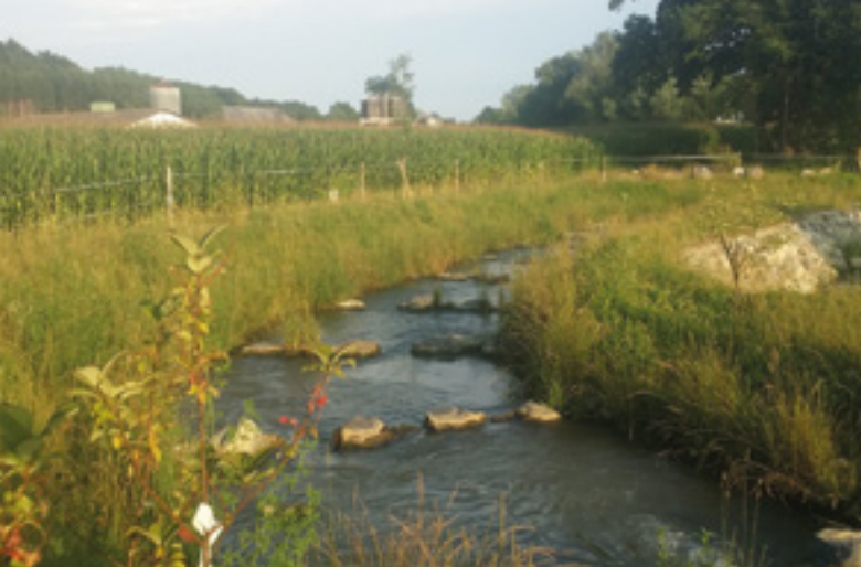
Abb. 34: Naturnaher Beckenpass - KW Clementmühle © Schifflerthner / IB Parthl
