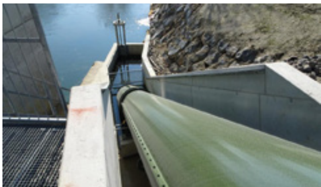
Abb. 41: Fischaufstiegsschnecke (System Rehart/Strasser) – KW Lugitsch © Schmid / IB Parthl
