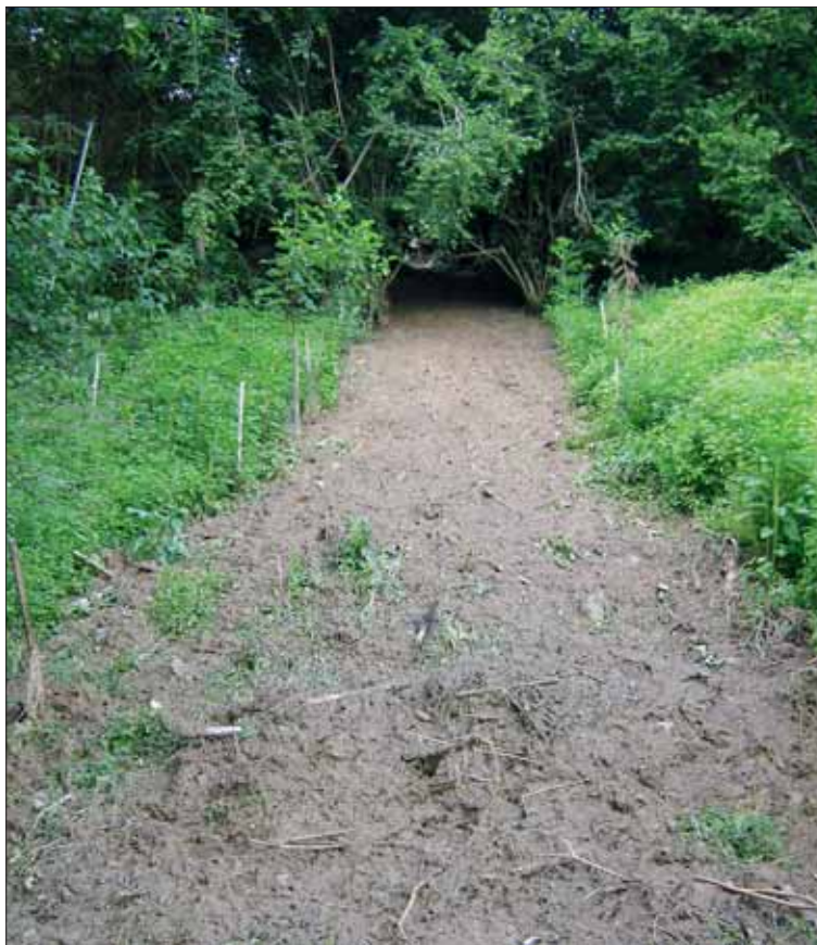
Abb. 4: Spuren eines von einer überlasteten Sickeranlage hervorgerufenen Schlammstromes
