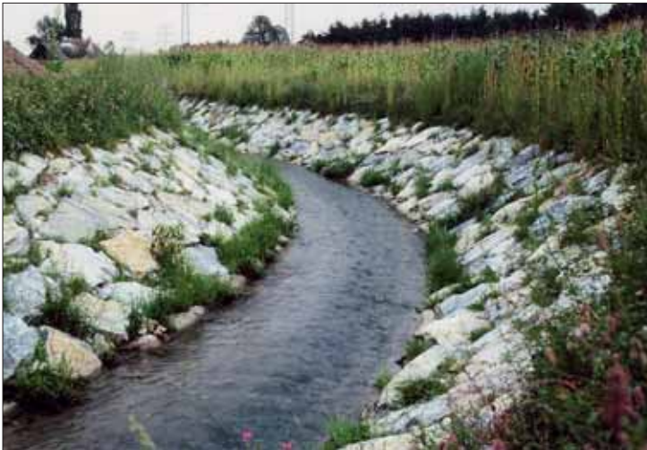
Abb. 9: Andritzbach-Ausbau im Jahr 1979: Geometrisches, monotones Regulierungsprofil mit Maisanbau ab der Uferoberkante
