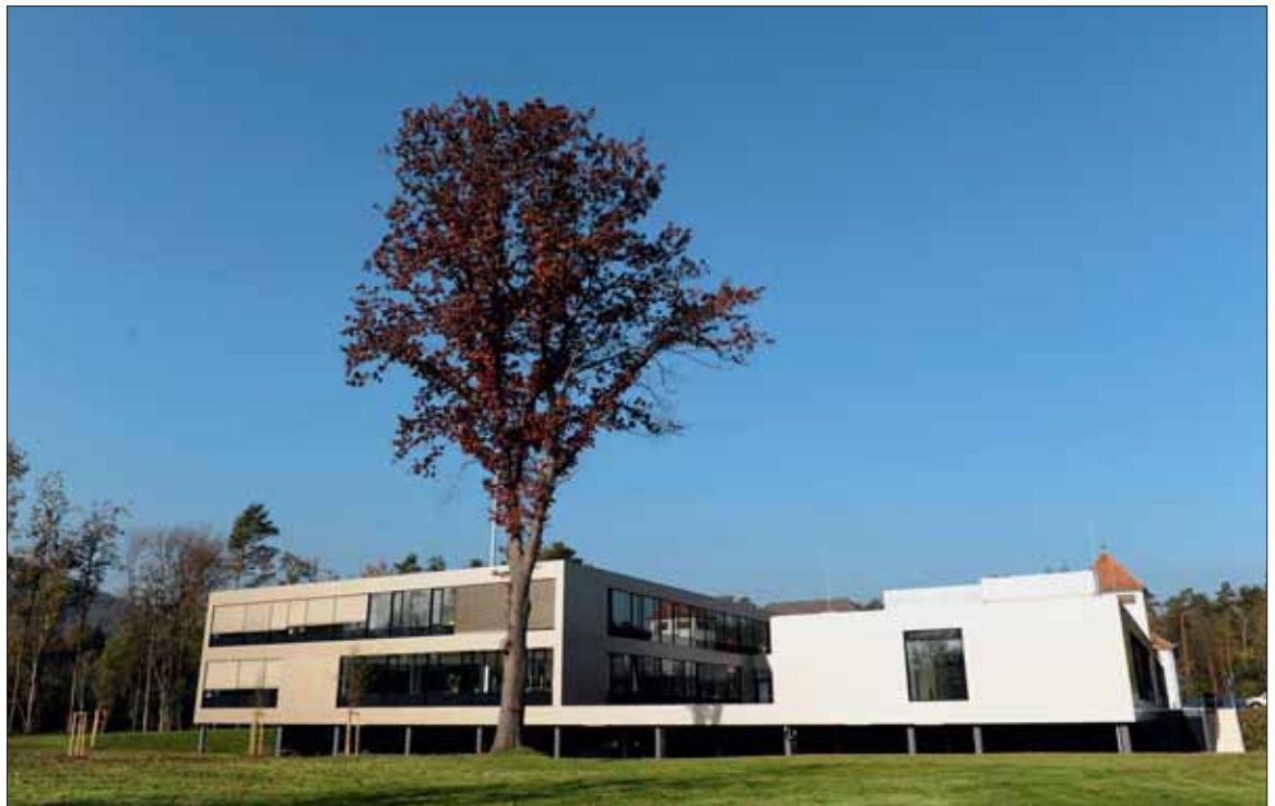
Abb. 1: Das neue Kompetenzzentrum in Graz Andritz (Holding Graz/Wasser)
