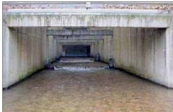
Abb. 6: Gestaltung des Grundablasses für die Migration von Fischen mit Natursteinen und Kaskaden
