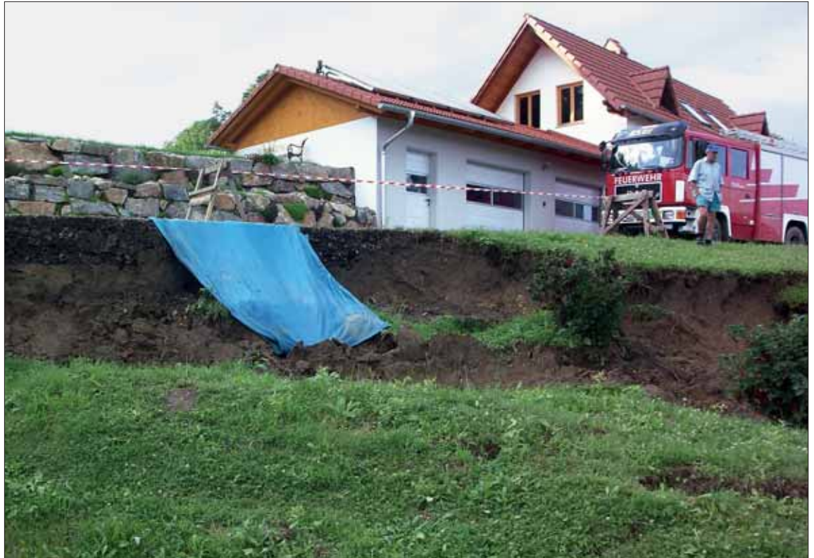
Abb. 7: Hangrutschung gefährdet Haus im Jahr 2009
