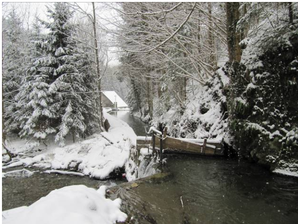
Abb. 21: Wehranlage KW Königshofer
