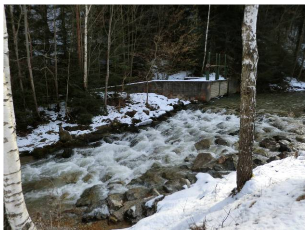
Abb. 13: Wehranlage KW Breitenbrunner
