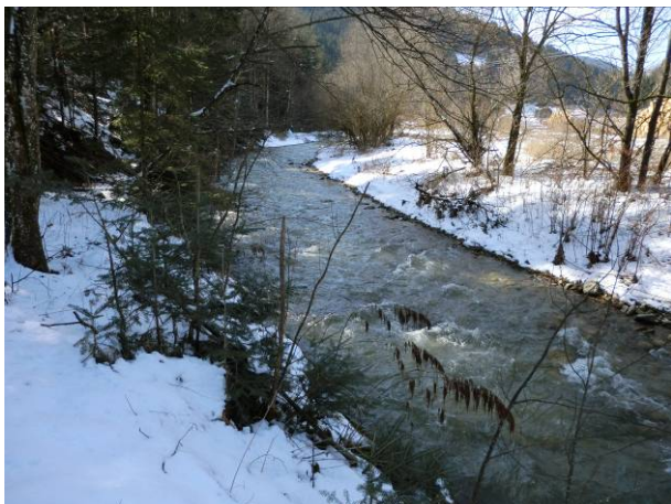
Abb. 27: KW Schiester Bereich Wehranlage
