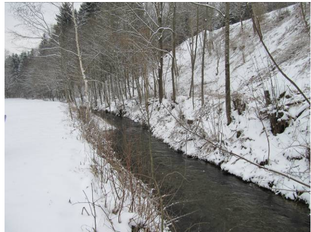
Abb. 17: Triebwasserrücklauf KW Ehrenhöfer
