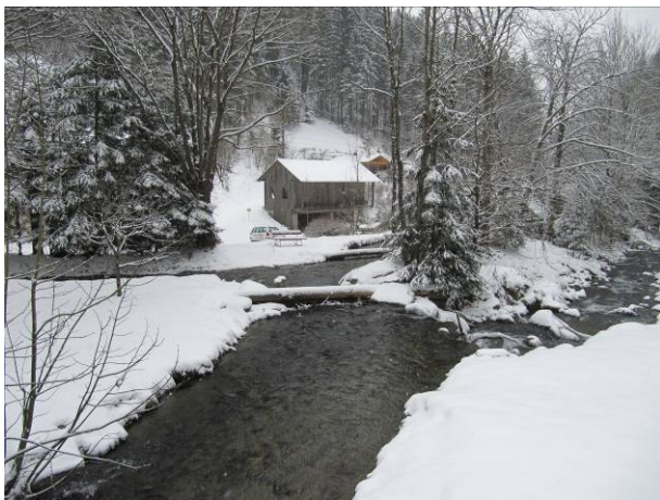
Abb. 19: Wehranlage KW Schwarz
