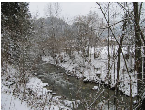
Abb. 30: KW Riegersberg Bereich Wehranlage
