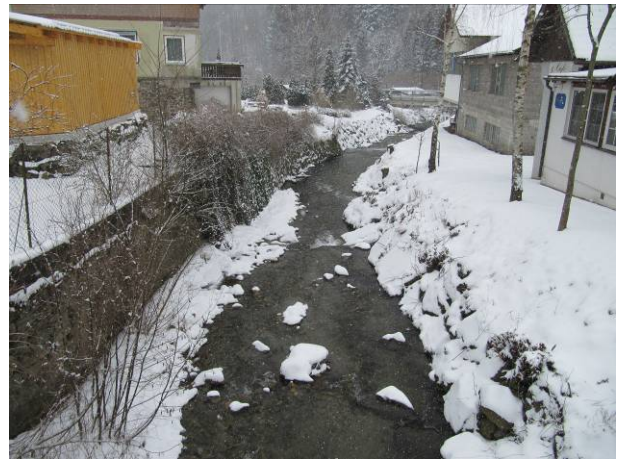
Abb. 26: Treibwasserrücklauf KW Fally
