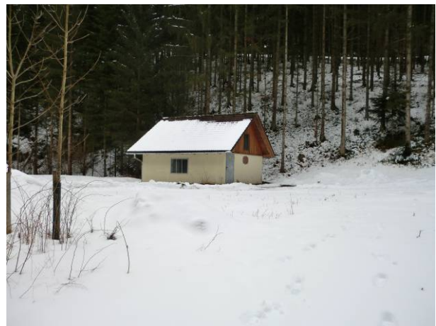
Abb. 11: Krafthaus KW Mayerhofer
