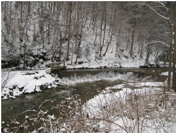
Abb. 16: Wehranlage KW Ehrenhöfer
