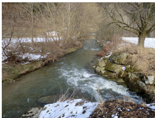
Abb. 14: Triebwasserrücklauf KW Breitenbrunner
