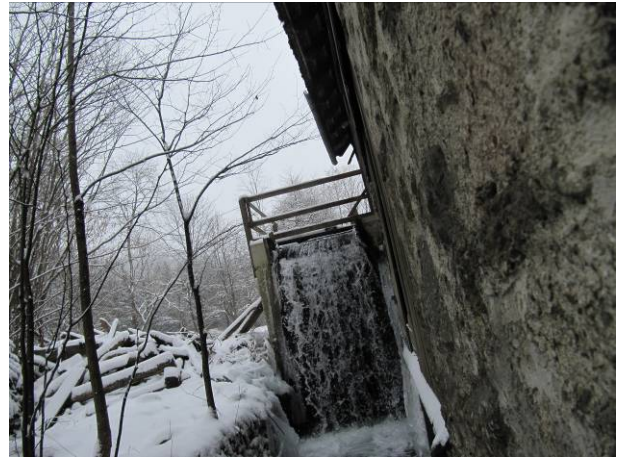
Abb. 24: Überlauf KW Grabner
