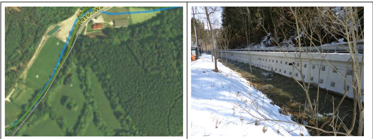
Abb. 7: Verlauf in unmittelbarer Straßennähe und entsprechende Verbauung
