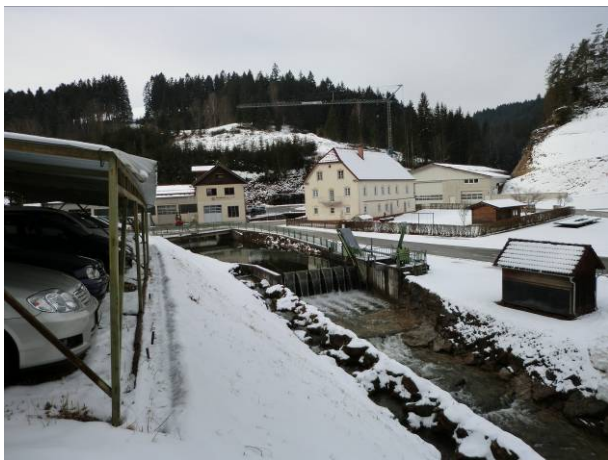
Abb. 10: Wehranlage KW Mayerhofer inkl. Fischeaufstiegshilfe orographisch rechts
