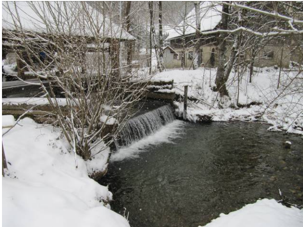
Abb. 23: Wehranlage KW Grabner
