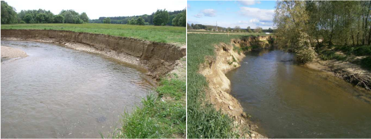
Abb. 17. Links: Uferanriss in einem gehölzfreien Abschnitt Höhe Loipersdorf-Kitzladen (23.05.2005). Rechts: Fehlende Pufferstreifen gegen die angrenzenden landwirtschaftlichen Flächen stromab der Safen-Mündung (April 2014).
