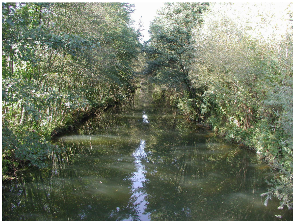
Abb. 7. Staustrecke stromauf der Wehranlage des KW Kottulinsky in Neudau (30.09.2002).
