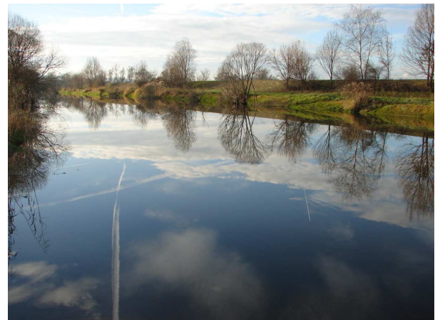
Abb. 8. Staustrecke stromauf der Sohlrampe unterhalb der Rittscheinmündung (Königsdorf; November 2006).
