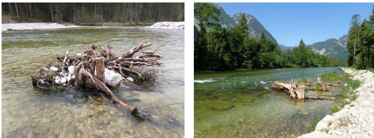
Abb. 5.6: Beispiele von Strukturelementen aus Wurzelstöcken.
