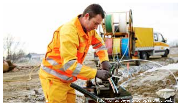
Foto: Konrad Beyer & Co. Spezialbau GmbH
