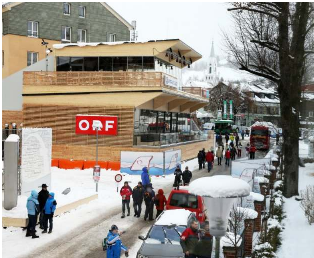
ORF Haus der Fa. Loidl kann bis zu 30mal auf-und abgebaut werden
