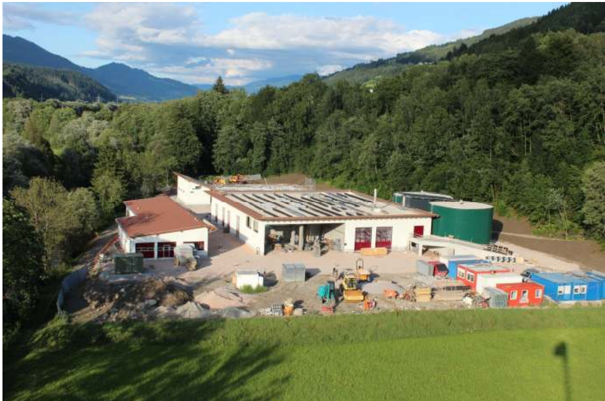
Die neue Kläranlage als Investition für Jahrzehnte
